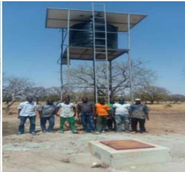
Foto 23 : Empfangnahme der Solar-Pumpenanlage
